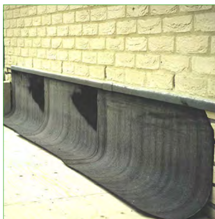
Eindsituatie met aangebracht dakbedekking.
