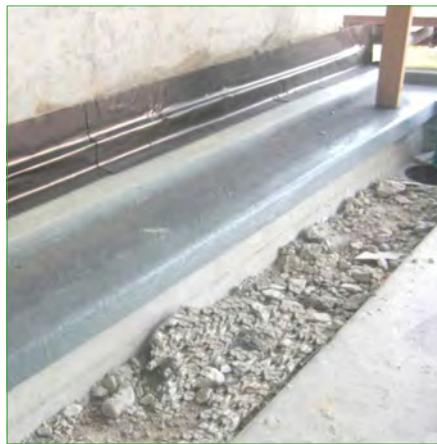
Geplaatst en luchtdicht afgeplakt
