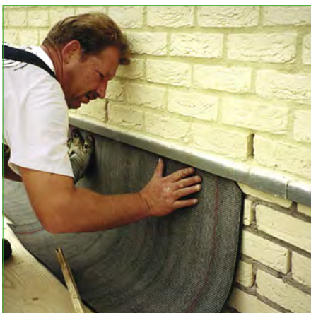
Zorg voor open stootvoegen voor het LV profiel.
