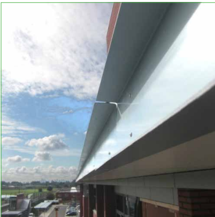
Polyester dakrand afwerking
