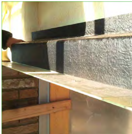
Loodervanger boven en om een geveldrager
