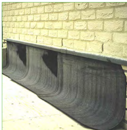
Eindsituatie met aangebracht dakbedekking.
