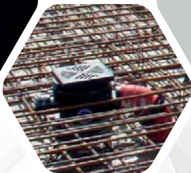
KRASO® Afvoerput kelder met folieflens
