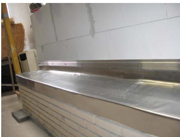
Fixeren aan ondergrond. Vastzetten met een knelstrip .....
