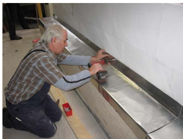
..... of direct vastschroeven op het binnenblad.
